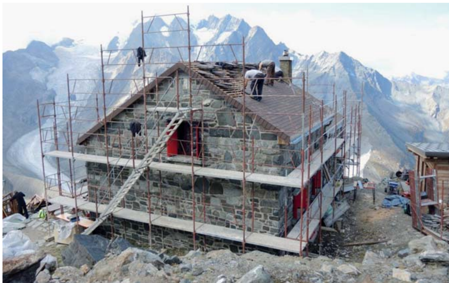
D'importants travaux d'entretien, dont le renouvellement du toit, ont été réalisés cet automne sur la cabane de Valsorey, sise à 3037 mètres d'altitude. CAS CHAUX-DE-FONDS
